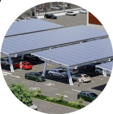
Solaire photovoltaïque en ombrières de parking
