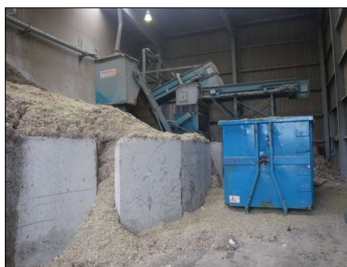
Stockage combustible de substitution
