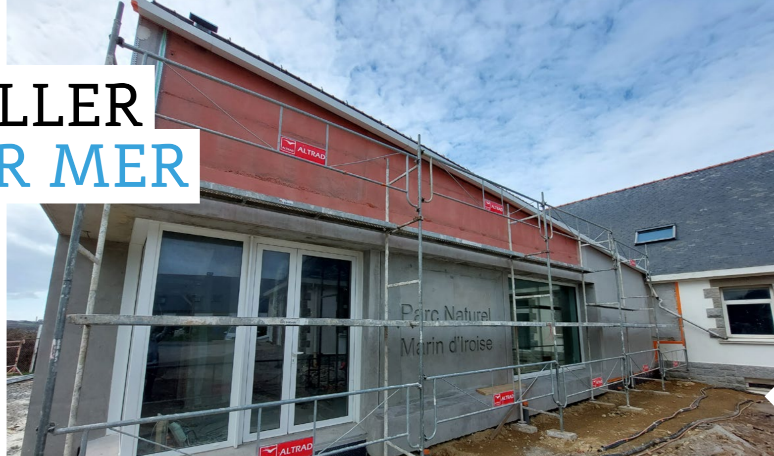
Extension du siège du Parc naturel marin d'Iroise : une nouvelle aile de 230 m² sur 2 niveaux. Fin des travaux pour l'été.
