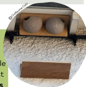
Nid d'hirondelle artificiel avec planche anti-salissure
