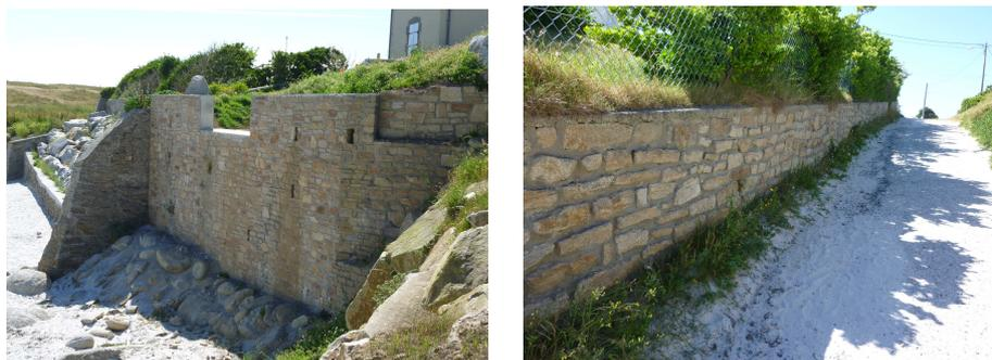
**Figure 20 : Drains visibles sur le mur de propriété et chemin d'accès**
