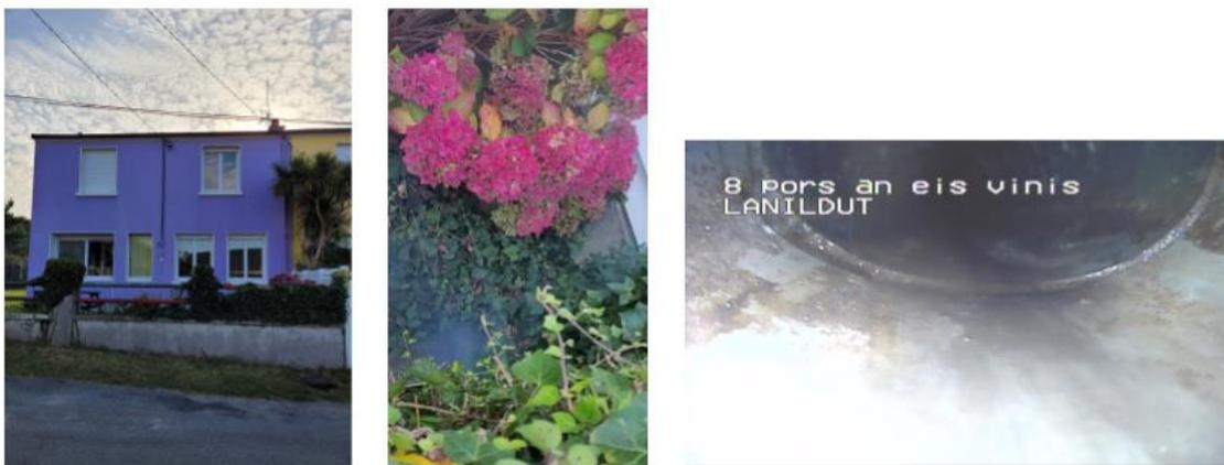
Figure 48. Résultat du test fumée et de l'inspection caméra du branchement de la propriété du n°8, route de Pors an eis Vinis.
