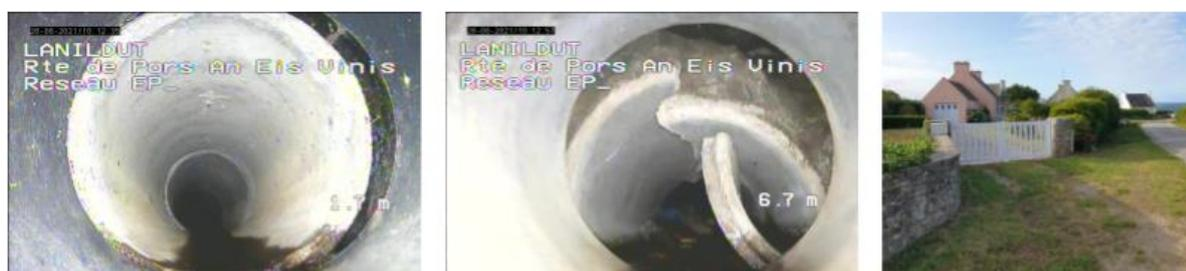
Figure 49. Point d'effondrement du réseau d'eaux pluvial au niveau de la propriété du n°16 route de Pors an eis Vinis.
