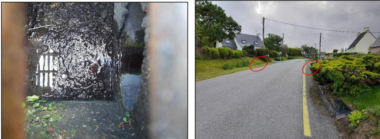
**Photo 13 : Ecoulement à l'intersection rue de Porsmilin et Blvd de l'Océan. Les écoulements viennent pour partie des deux fossés du Boulevard (zones entourées) (LABOCEA)**
