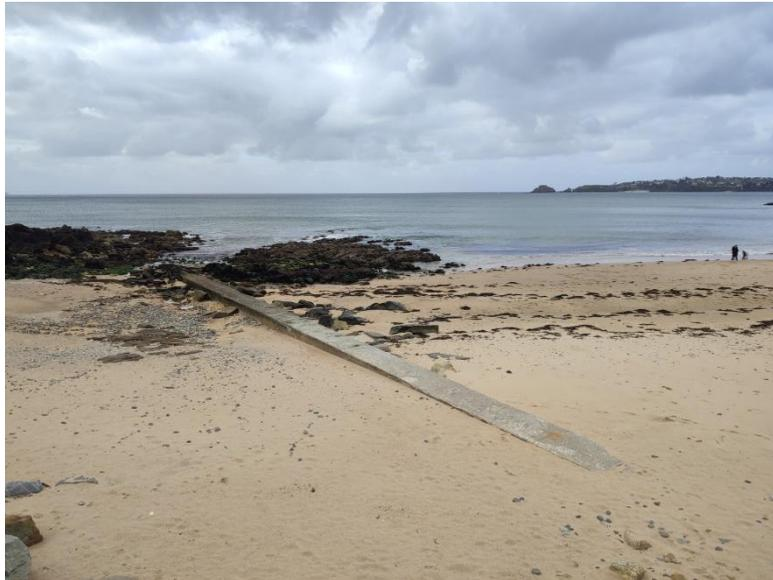
**Photo 4 : Exutoire du ruisseau et des eaux pluviales (Source : LABOCÉA)**
