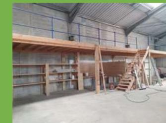
Création d'une mezzanine de stockage dans le hangar du centre nautique de Plougonvelin avec la création d'un escalier sur mesure
